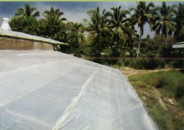
การติดตั้งพลาสติกเข้ากับรางน้ำและท่อเหล็กอลูมิเนียมที่นำมาประยุกต์ใช้
