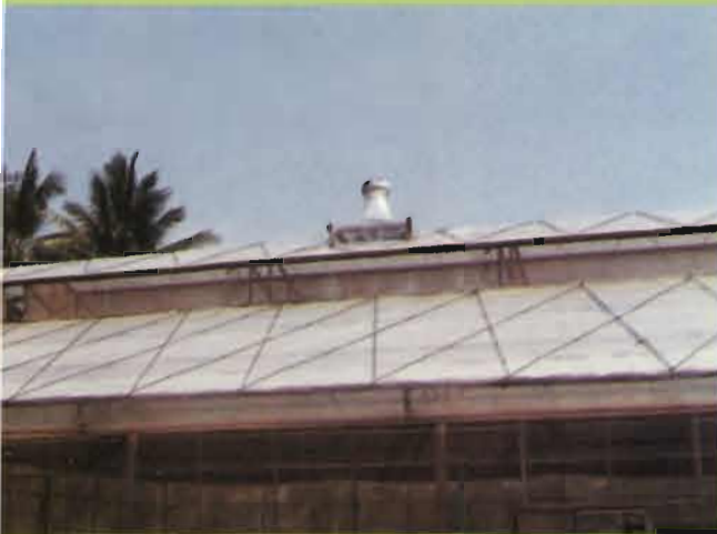
การชิงเชือกไนลอนพาดพลาสติกบนหลังคาเรือนโรง
